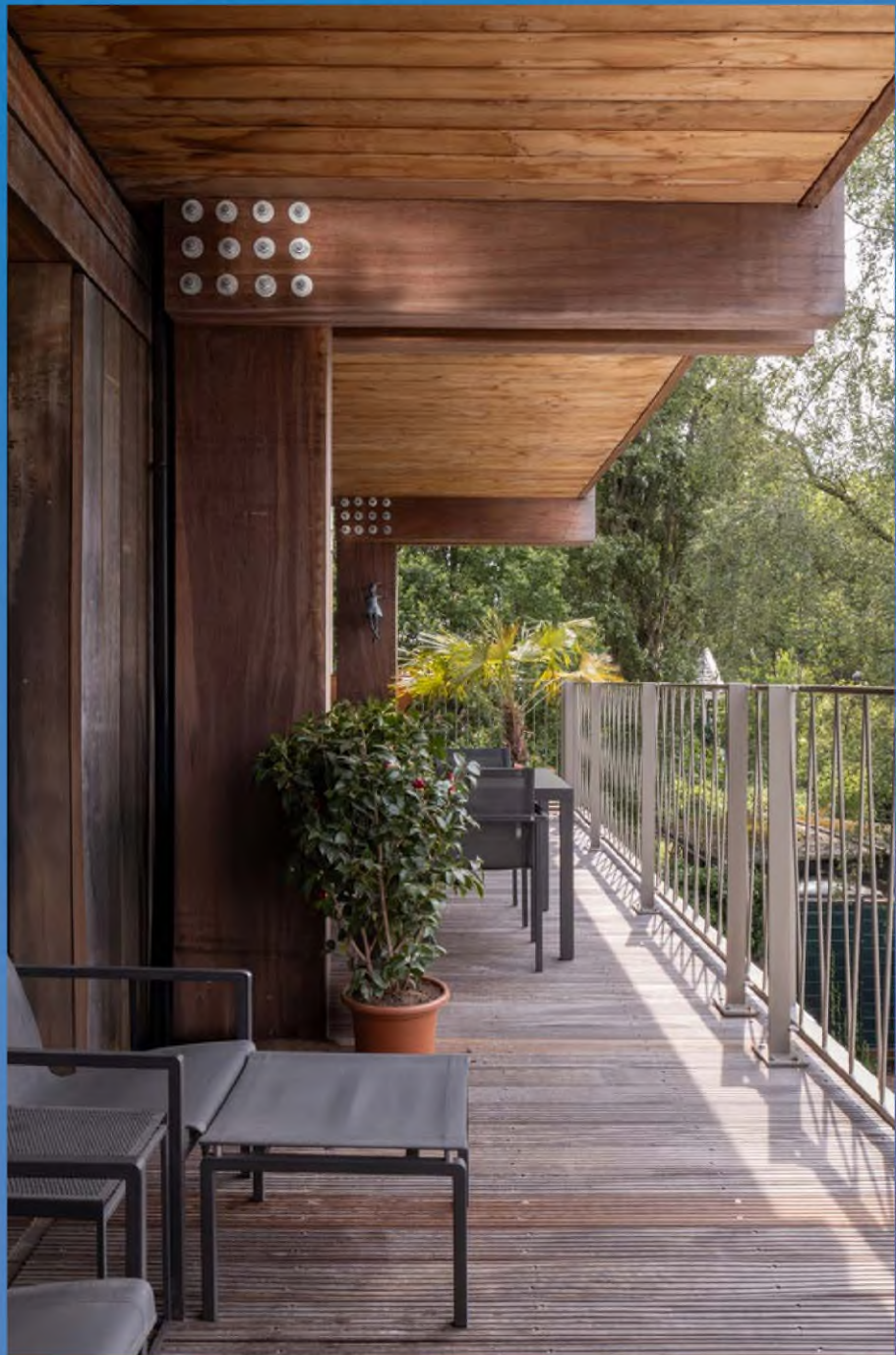
Abbeelding 39, 40 & 41. Het appartementencomplex Houtrak heeft gerecycled Azobé houten gevels en massief houten balkons, en is opgebouwd uit houten kolommen en prefab betonplaten. Zo is een flexibel casco ontstaan met flexibiliteit in de indeling en het gebruik. Houtrak Amsterdam (2025), Marcel Lok Architecten in samenwerking met Workshop Architecten en Flux Landscape. Foto: Anna Odulińska.
