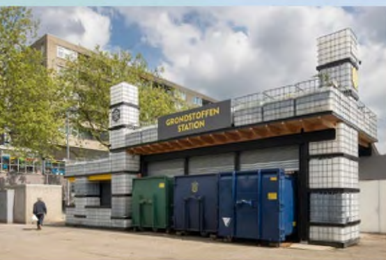
Afbeelding 98 & 99. Het Grondstoffenstation werkt samen met de wijk aan een sociale en duurzame circulaire wijk economie. Het paviljoen levert diensten op het gebied van afvalverwerking, catering, schoonmaak, vervoer, textielproductie, beheer, kennis en cultuur. Tegelijkertijd is het een ontmoetingsplek. Grondstoffenstation Rotterdam (2023) Superuse Studio. Foto: Frank Hanswijk.
