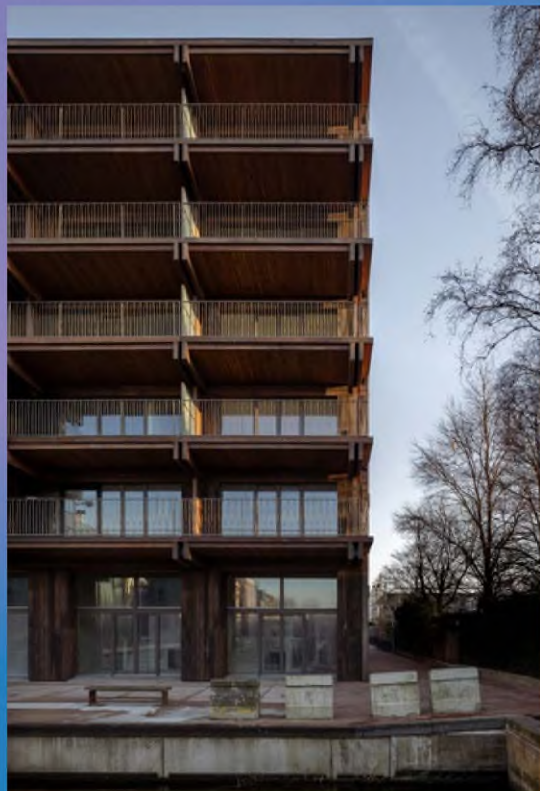
Abbeelding 39, 40 & 41. Het appartementencomplex Houtrak heeft gerecycled Azobé houten gevels en massief houten balkons, en is opgebouwd uit houten kolommen en prefab betonplaten. Zo is een flexibel casco ontstaan met flexibiliteit in de indeling en het gebruik. Houtrak Amsterdam (2025), Marcel Lok Architecten in samenwerking met Workshop Architecten en Flux Landscape. Foto: Anna Odulińska.
