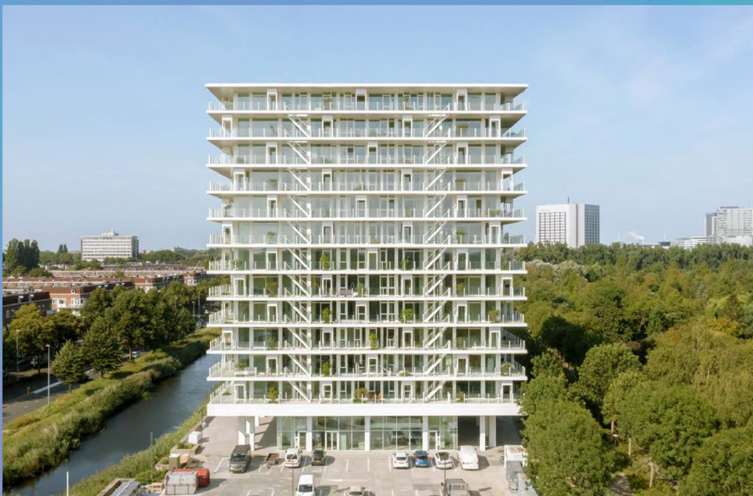
Afbeelding 62. De Voortuinen (2021) in Amsterdam is een voormalig ING kantoor dat is getransformeerd tot wooncomplex. De bestaande constructie is behouden en aangepast. In de toren zitten nu 94 woningen voorzien van rondlopende balkons met daarin plantenbakken voor boompjes. Ontwerp: Elephant. Foto: Marcel van der Burg.
