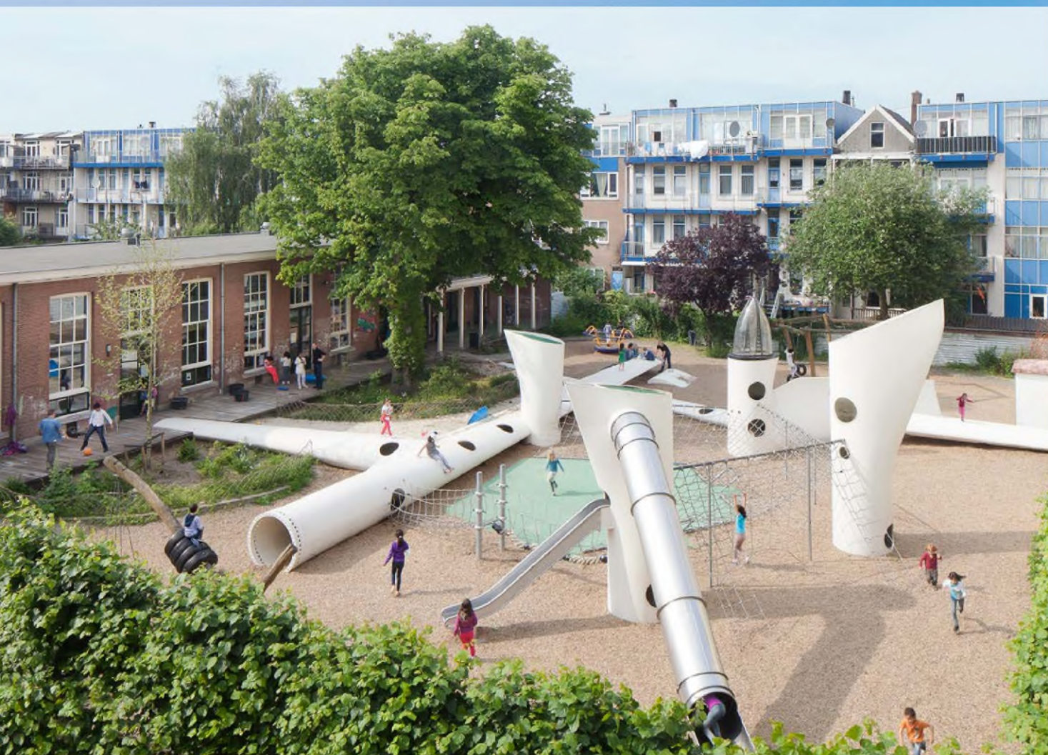
Afbeelding 81. Speeluin Wikado in Rotterdam (2008) transformeert vijf afgedankte windmolenwieken tot een avontuurlijke, labyrintachtige speelplek met torens, klimnetten en een pannakooi. Door het hergebruik van de wieken en materialen bespaart het project circa 90% CO 2 ten opzichte van een reguliere speeluin. De abstracte vormen prikkelen de fantasie van kinderen en geven ruimte aan steeds nieuw spel. Ontwerp: Blade Made, Superuse. Foto: Denis Guzzo.
