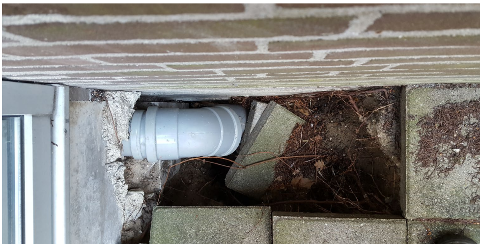
Figuur 3.8: Een kapot riool trekt ratten aan (bron: Alex Mars, Mega-Des).
