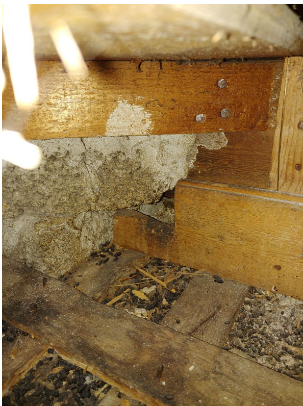
Figuur 3.9: Oude plafonds zijn aantrekkelijk voor ratten en muizen (bron: Alex Mars, Mega-Des).
